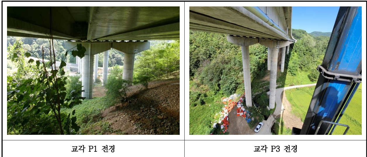
【사진 12.3.10】 교각 전경
