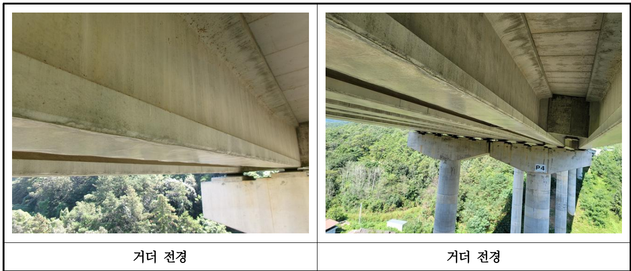
【사진 12.3.4】 거더 전경
