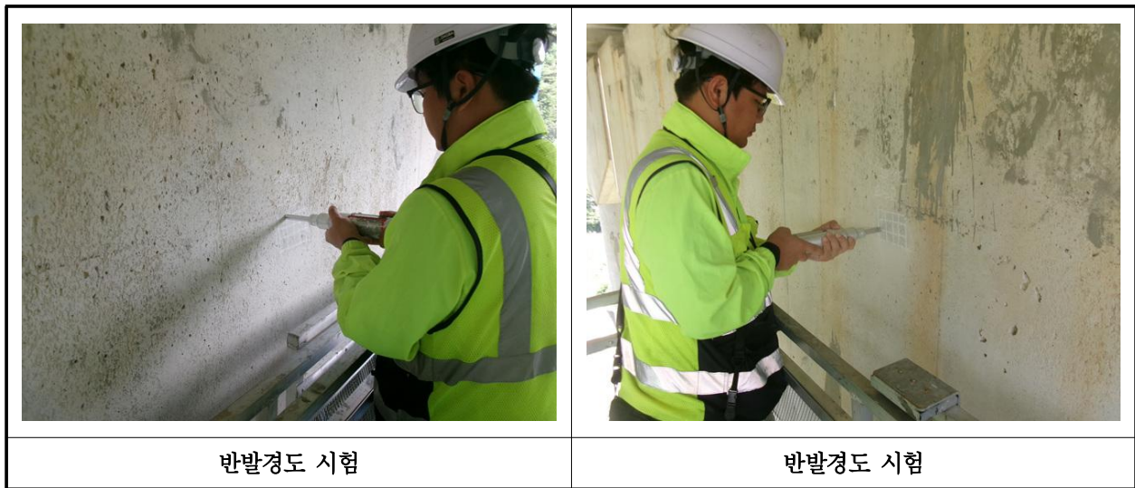
【사진 12.4.2】 반발경도시험 현장사진
