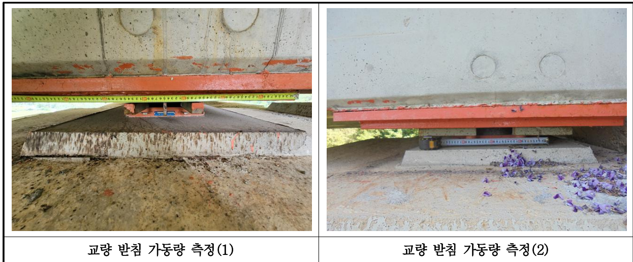
【사진 12.3.41】 교량받침 이동량 측정
