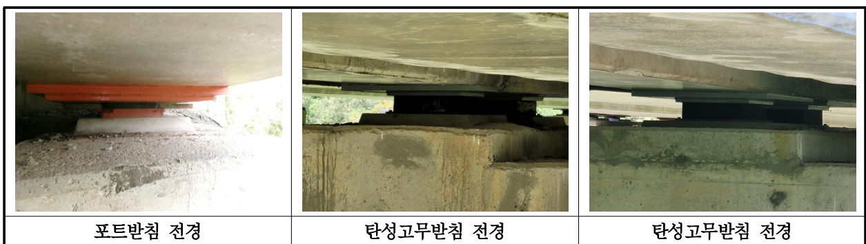
【사진 12.3.13】 교량받침 전경
