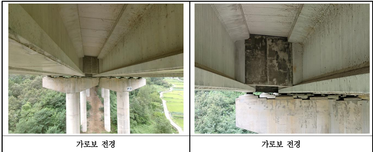
【사진 12.3.31】 가로보 전경
