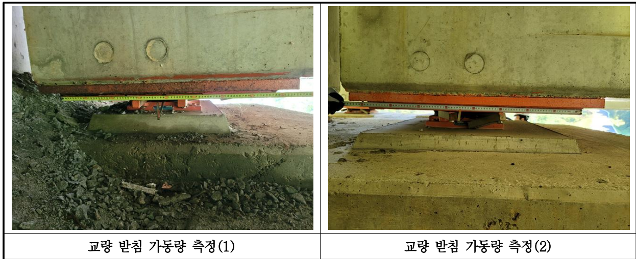
【사진 12.3.16】 교량받침 이동량 측정
