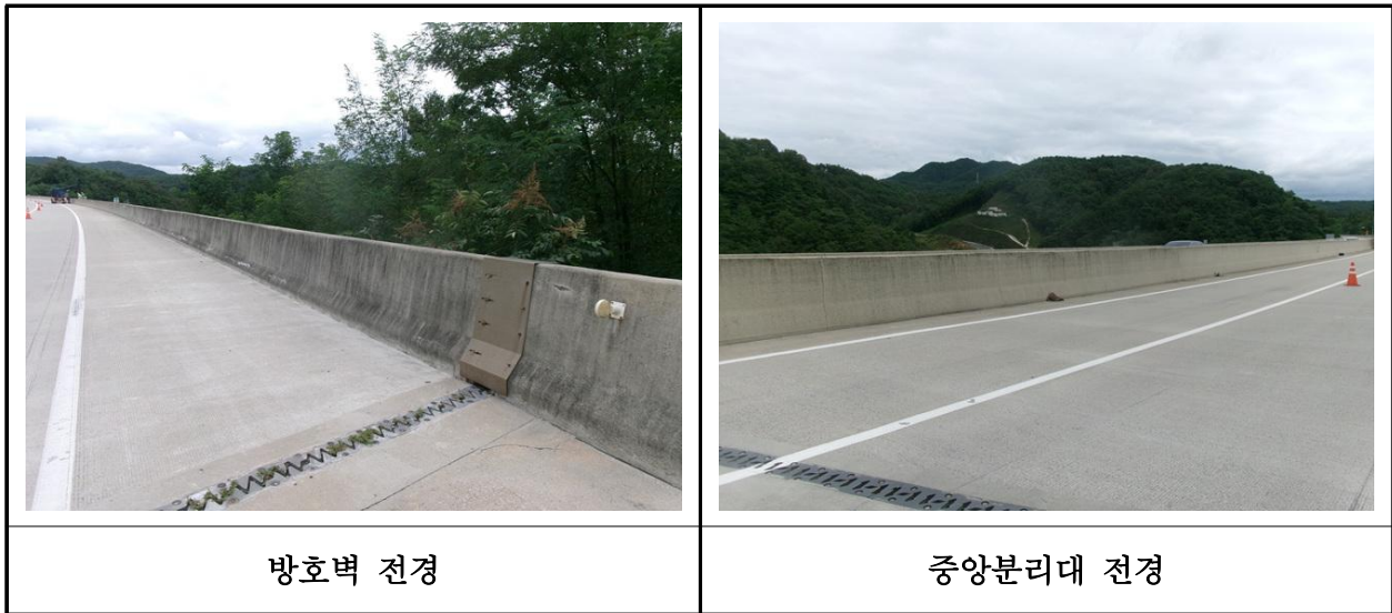
【사진 12.3.49】 방호벽 및 중앙분리대 전경
