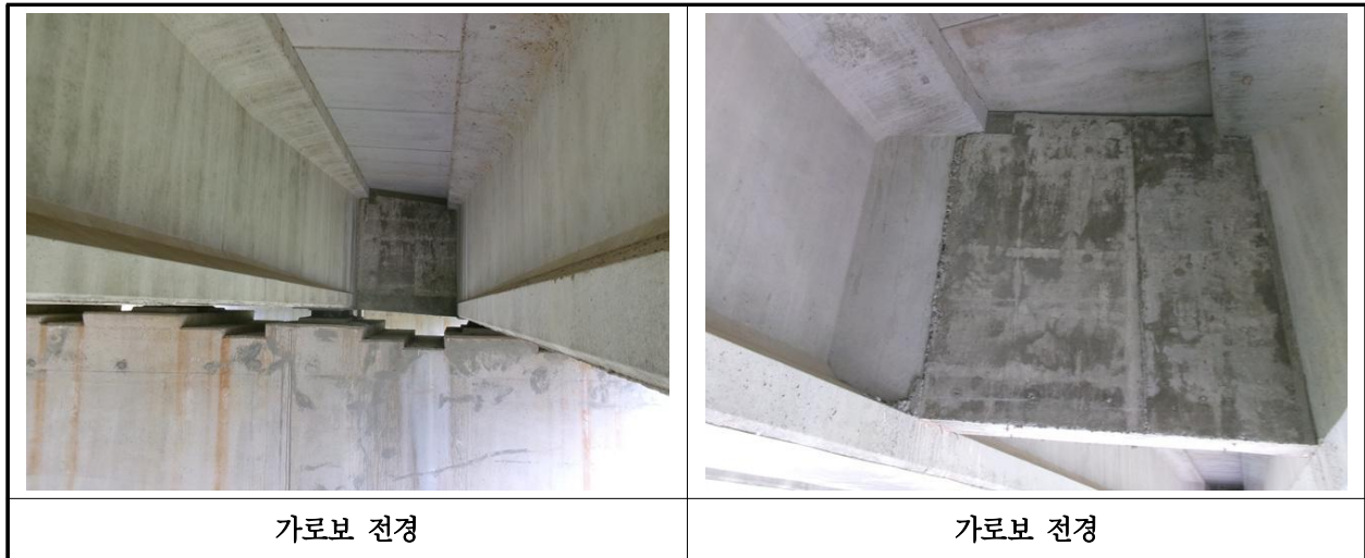
【사진 12.3.6】 가로보 전경
