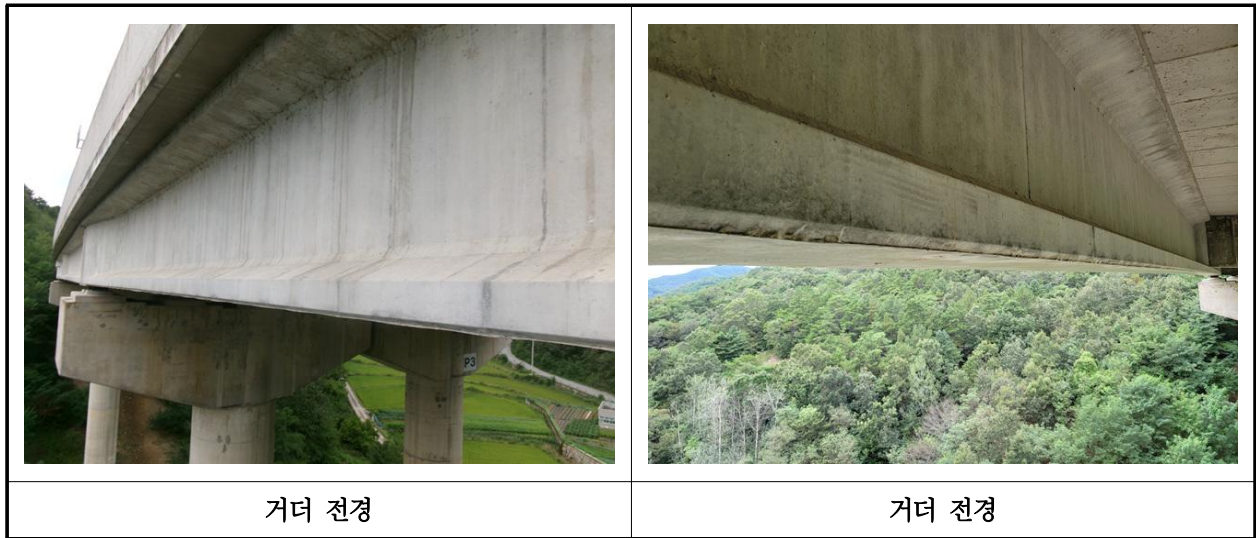
【사진 12.3.29】 거더 전경
