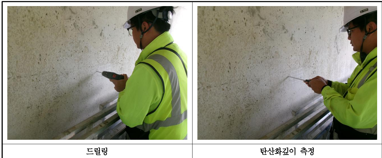
【사진 12.4.3】 탄산화 깊이 측정 현장사진
