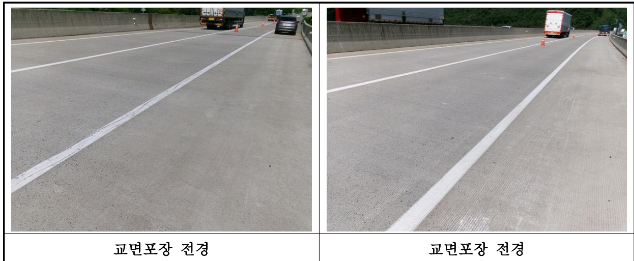
【사진 12.3.20】 교면포장 전경
