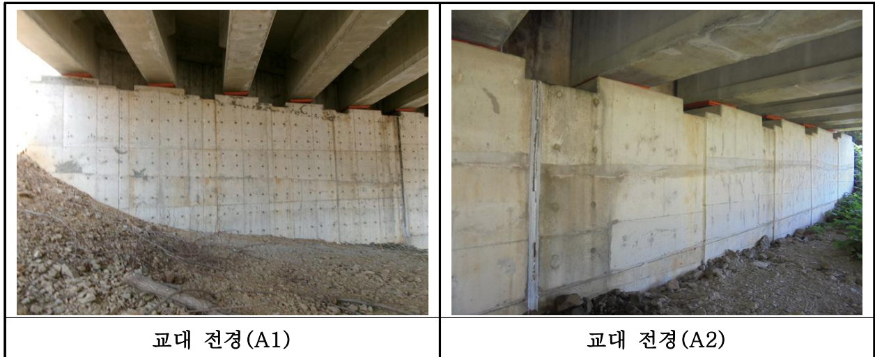
【사진 12.3.33】 교대 전경
