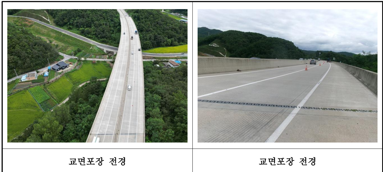
【사진 12.3.45】 교면포장 전경
