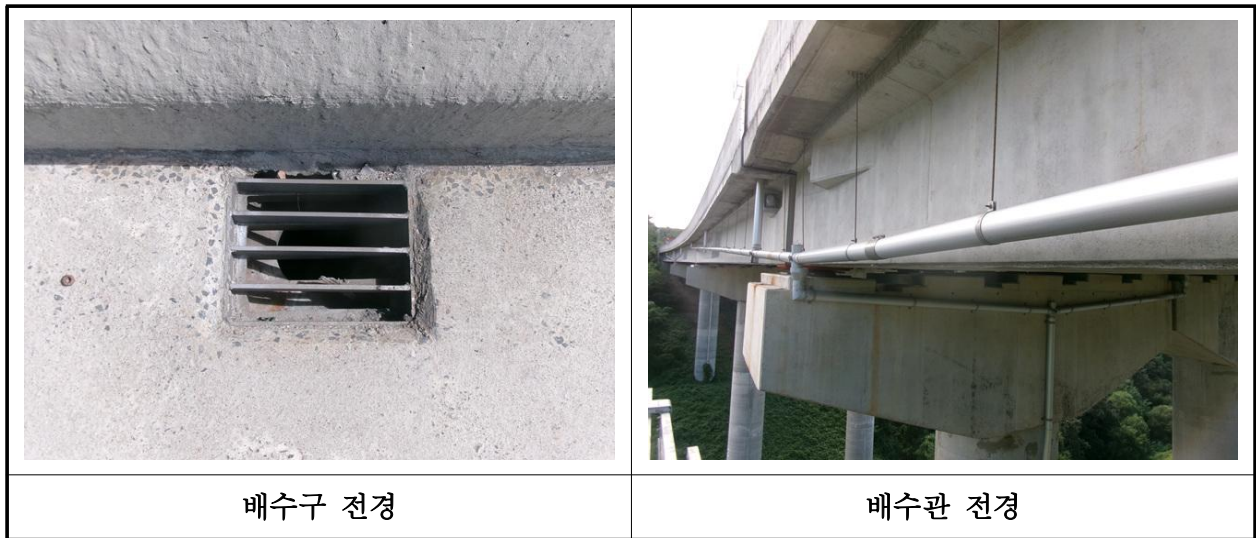
【사진 12.3.22】 배수시설 전경
