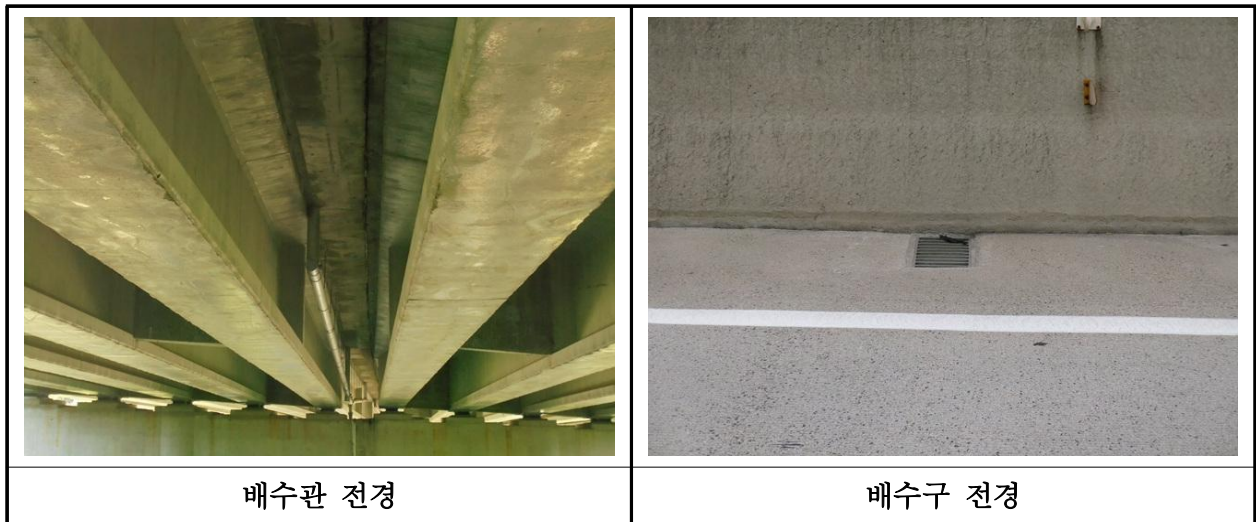
【사진 12.3.47】 배수시설 전경
