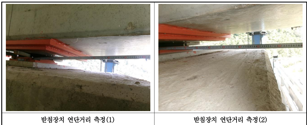
【사진 12.3.15】 교량받침장치 연단거리측정
