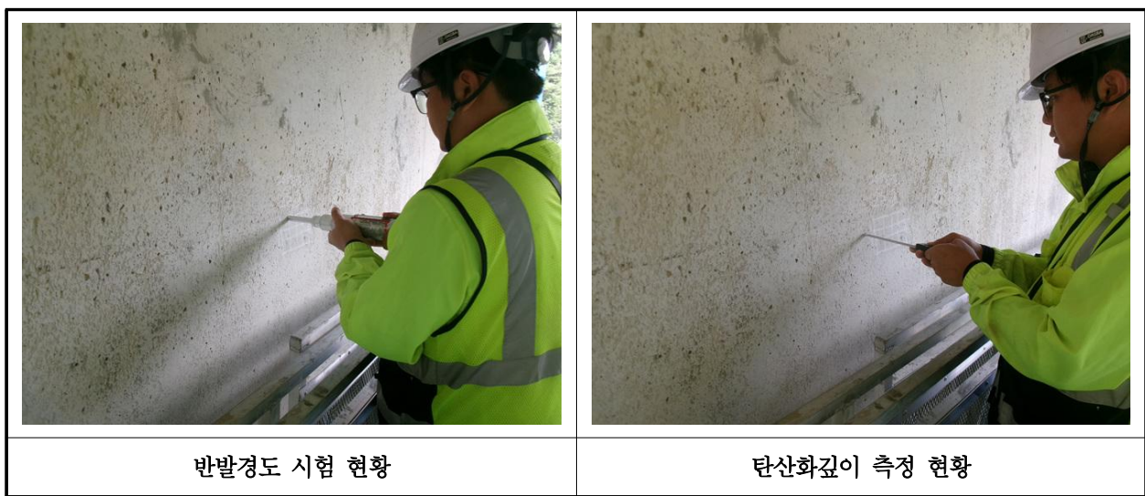
【사진 12.4.1】 콘크리트 내구성조사 현황
